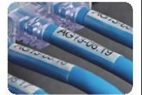
④ケーブルマーキング
