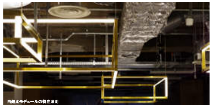
白銀比モジュールの特注照明
