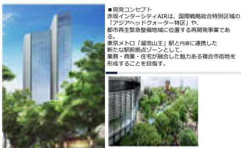
▲赤坂インターシティAIR外観
