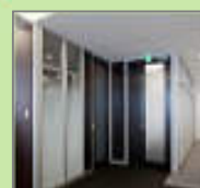
▼07...サーバールーム
