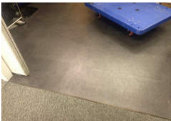
サーバールーム、倉庫はフラットな床で 機能性重視
