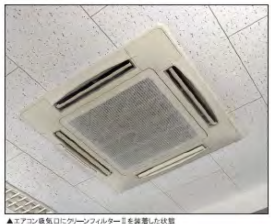
▲エアコン吸気口にクリーンフィルターIIを装着した状態
